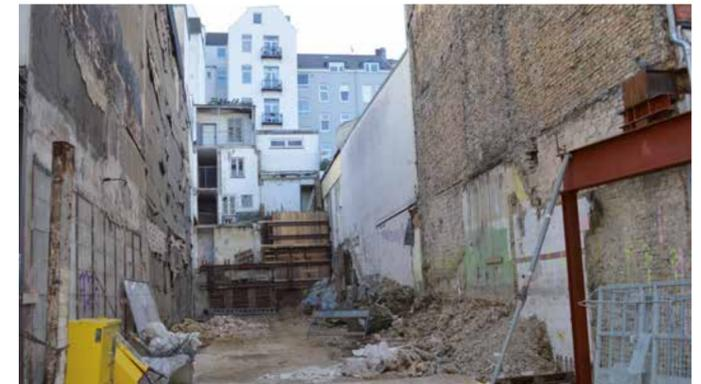
chert und die Fassade mit einer Stahlkonstruktion abgefangen. Zum Südergraben hin entstand zur Substanzsicherung ein sogenannter „Essener Verbau“. Dieser konnte auf Grund einer alten HDI-Unterfangung des Parkhauses Holm 42 nicht vollständig erstellt werden, die Ergänzung erfolgte durch eine aufwendige Stahlkonstruktion. Dabei erwies sich, dass auch das Nebengebäude Holm 48 im hinteren Bereich nicht ausreichend gegründet war und
