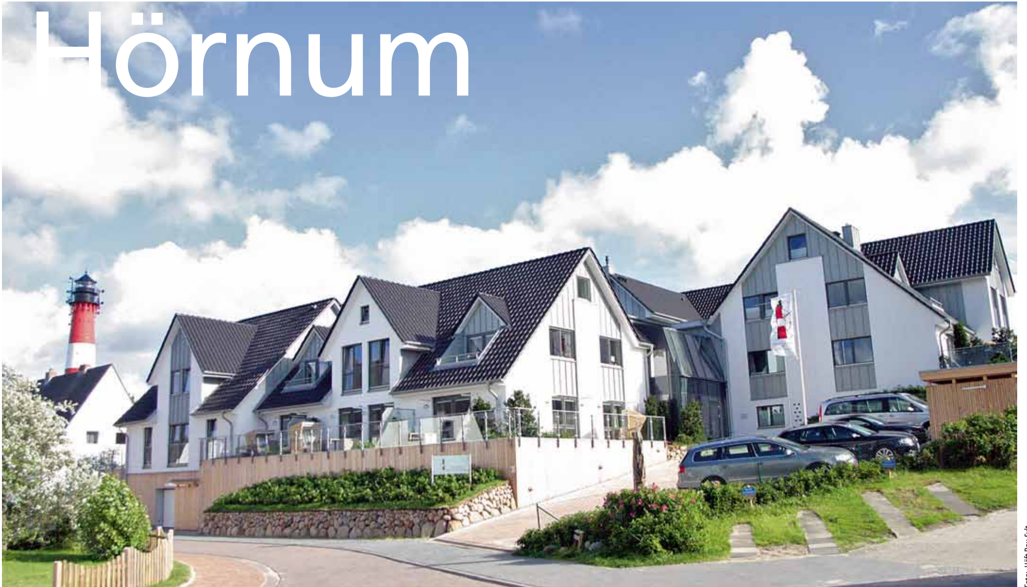
Foto: Höft Bau Sylt
