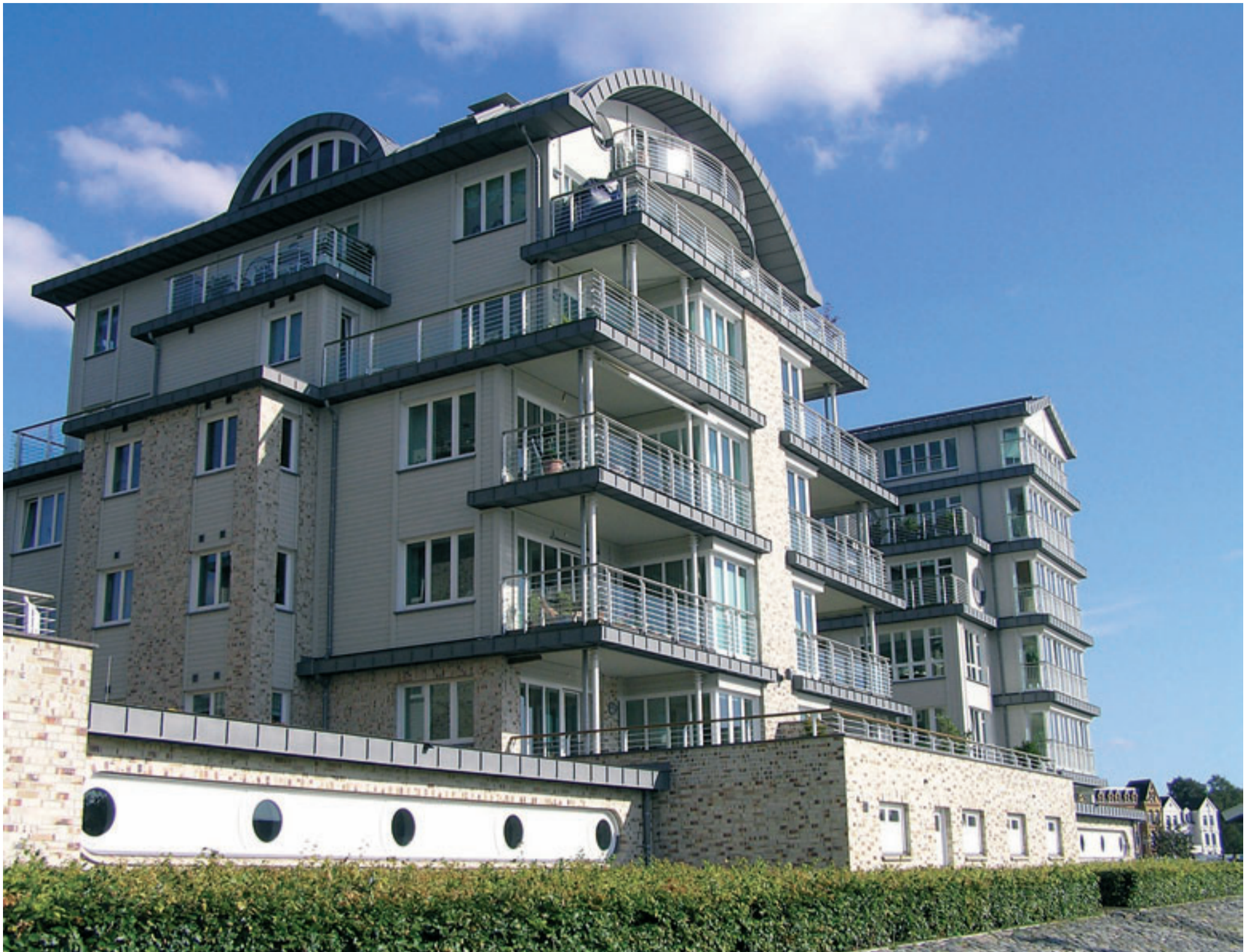
Kohlebrandklinker als bestimmendes Material im Sockel- und Treppenhausbereich.
